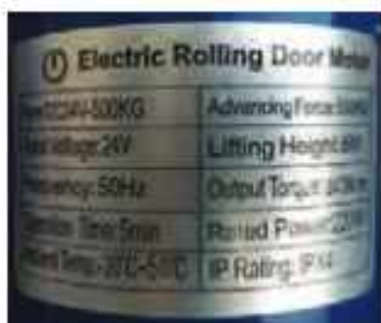
شکل ۱۰ - پلاک موتور در خودکار
