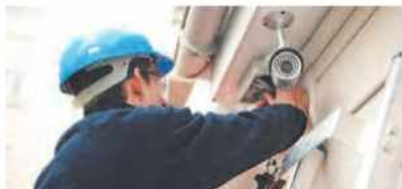
شکل ۲۹- نصب دوربین در فضای مناسب
