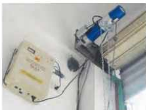
شکل ۱۵- یو پی اس مناسب برای در کرکره‌ای
