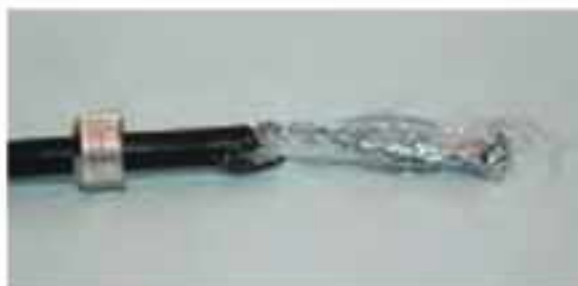
۲- کابل را به اندازه حدود ۲ سانتی متر روکش برداری کنید و پیچ یدنه خارجی را مشابه شکل از داخل آن رد کنید.
