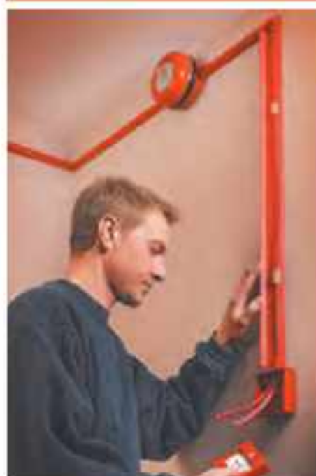
شکل ۲۰- گلند مقاوم در برابر حریق
